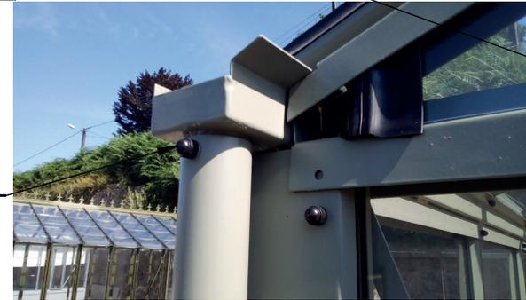
Collier de fixation pour tube Ø50
