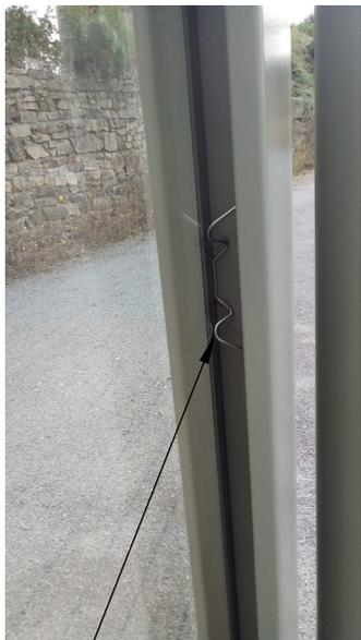
Clips W pour blocage vitrage au niveau sous toile de coin
