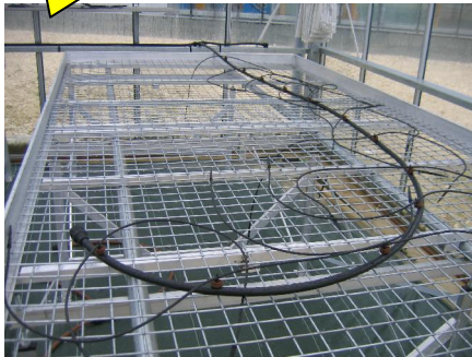
Rampe GOUTTE à GOUTTE
