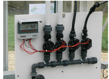
Programmateur 4 voies + électrovannes + nourrice (option programmeur livré avec 1 nourrice 2 voies et 1 électrovanne)
